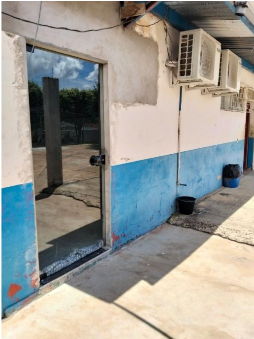
acesso para biblioteca.
