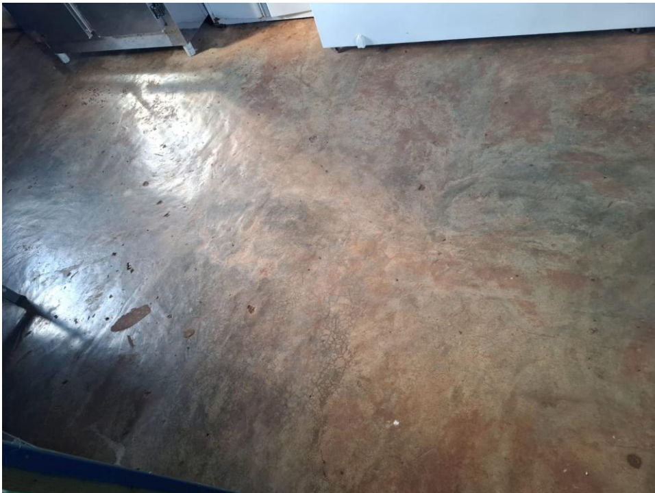
Piso da Cozinha e Piso dos banheiros
