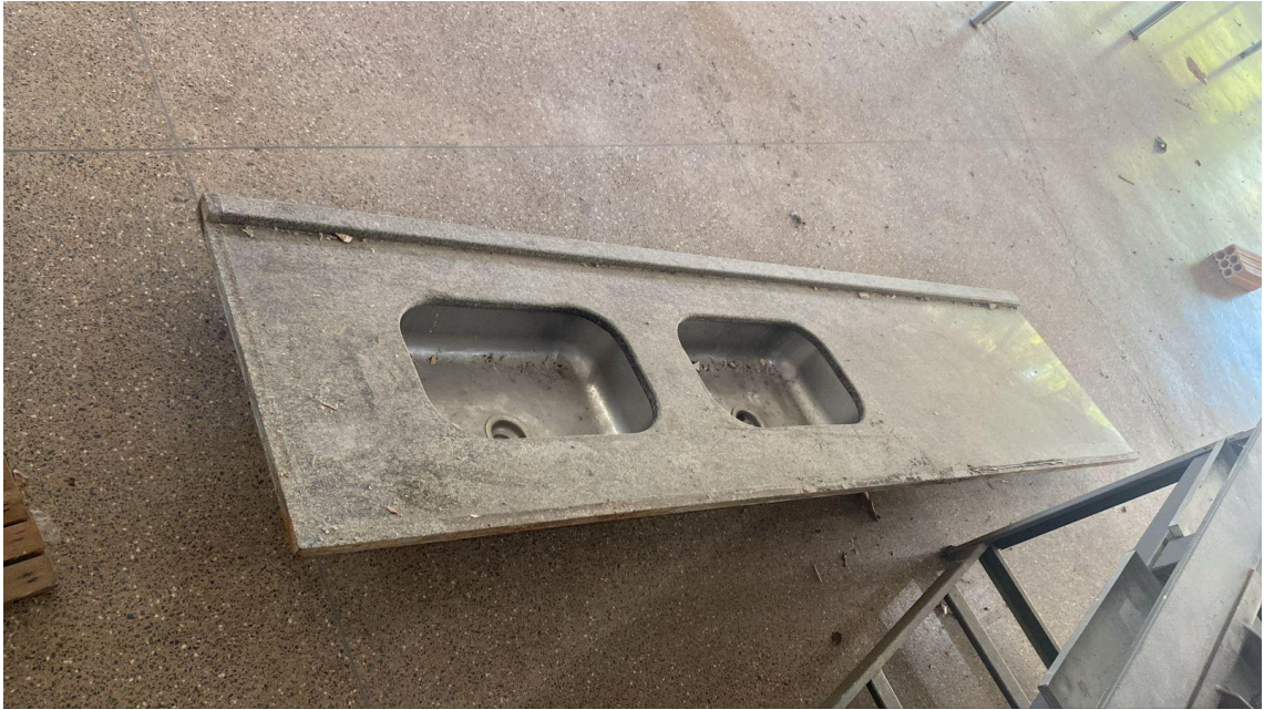
Figura 5 Essa pia será reformada junto com bancada e trocada a cuba por uma maior
