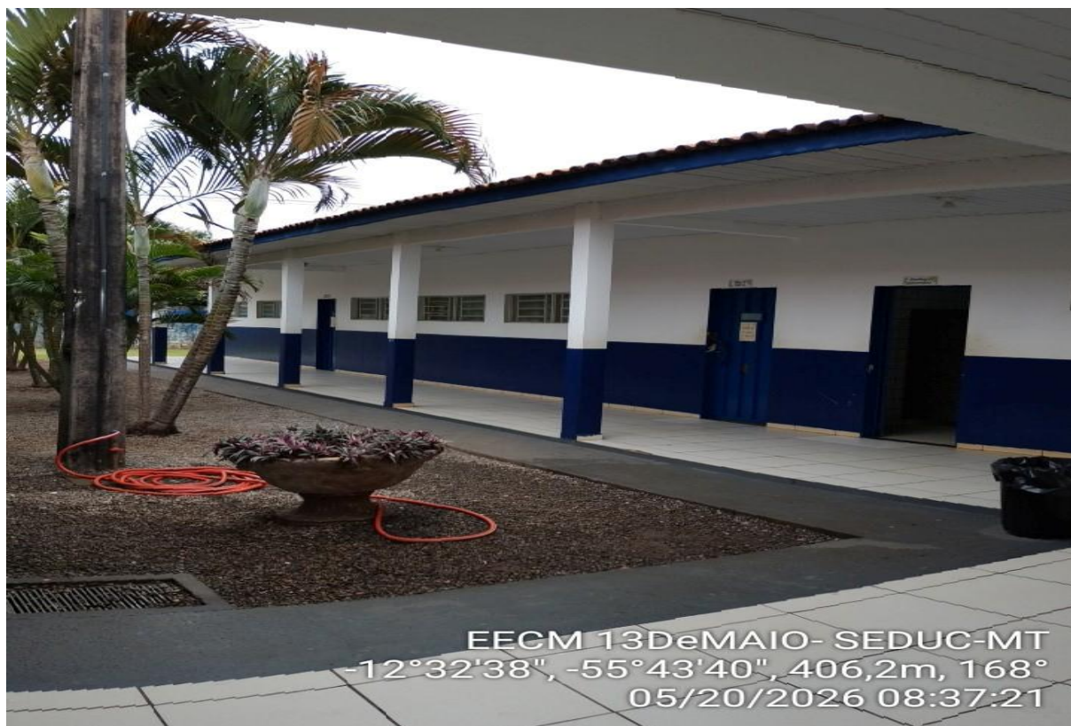
Bloco B – lado esquerdo (telhado atual)
