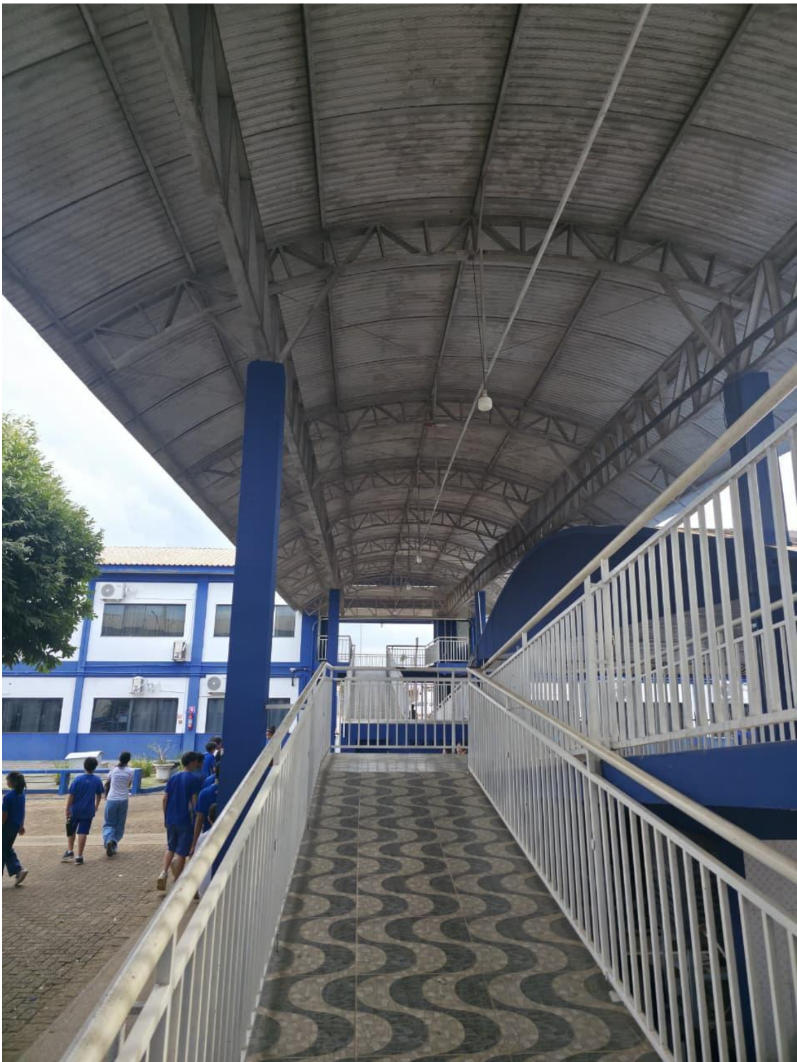
Pintura 25X7X2 lados - interno e externo etapa 2
