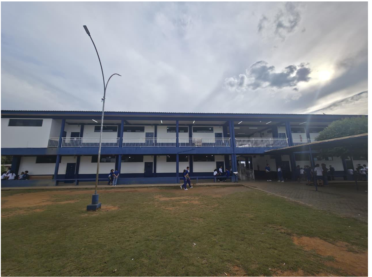
50X10 - pintura da cobertura de 1 pavilhão - etapa 3
