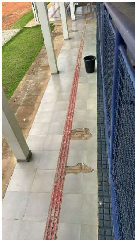
Piso lateral esquerda da rampa – térreo.
