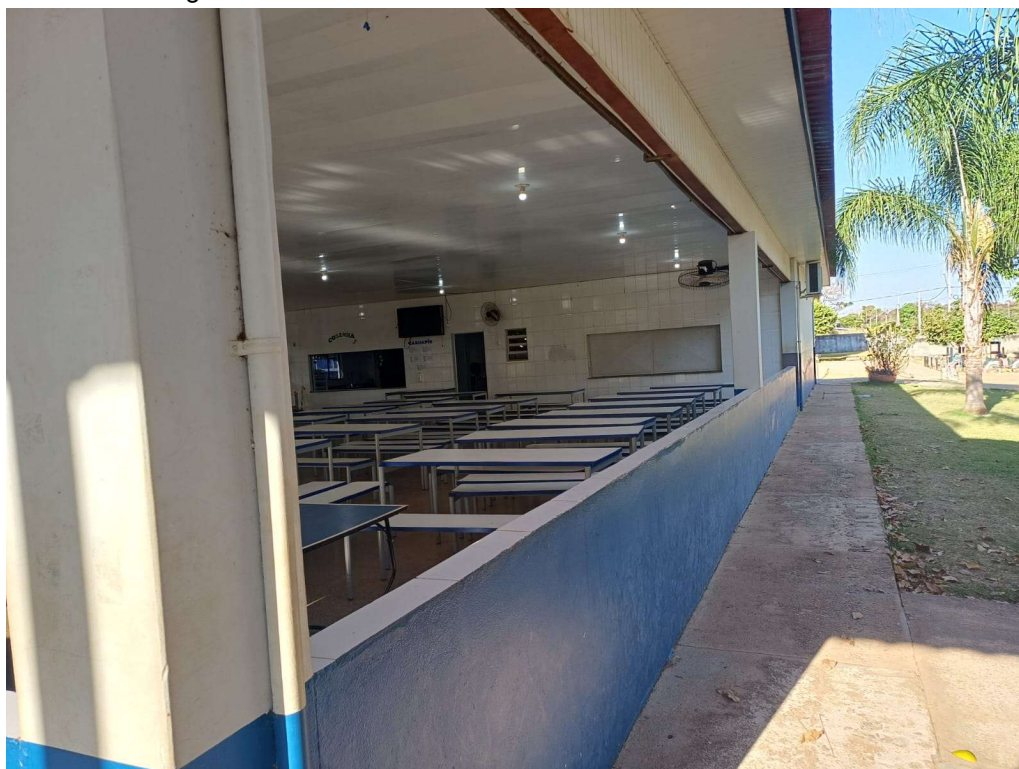
Figura 2 – Vista externa da alvenaria existente do refeitório.
