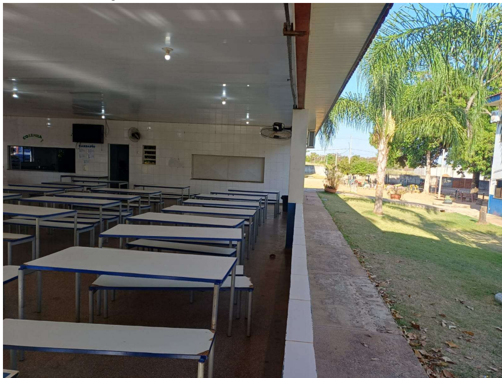
Figura 1 – Vista do refeitório e da alvenaria existente.
