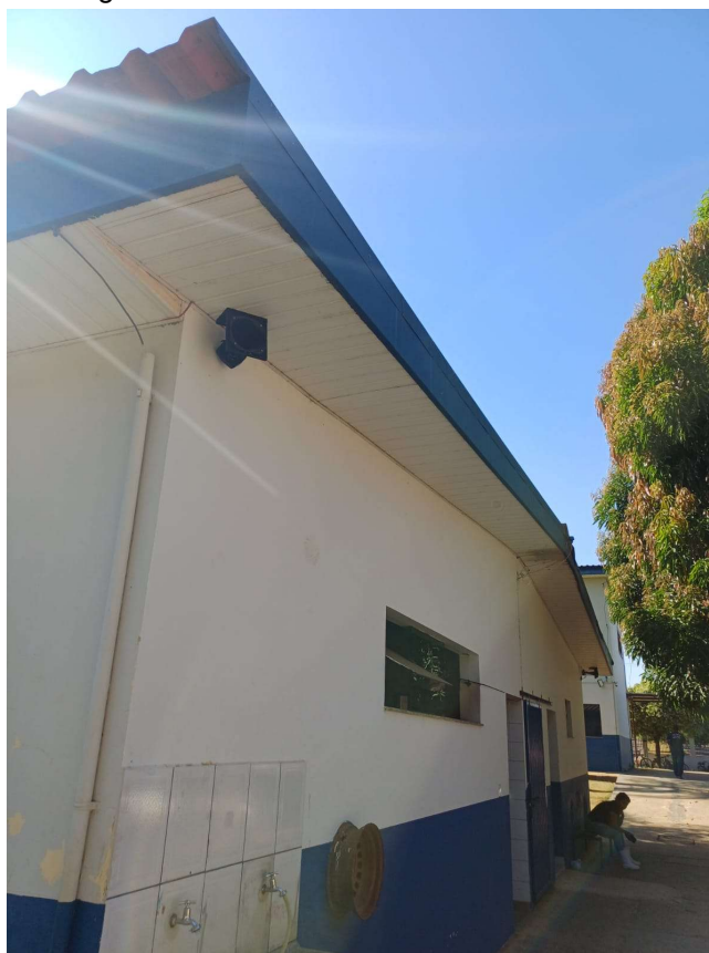
Figura 3 – Vista externa do forro e do beiral.
