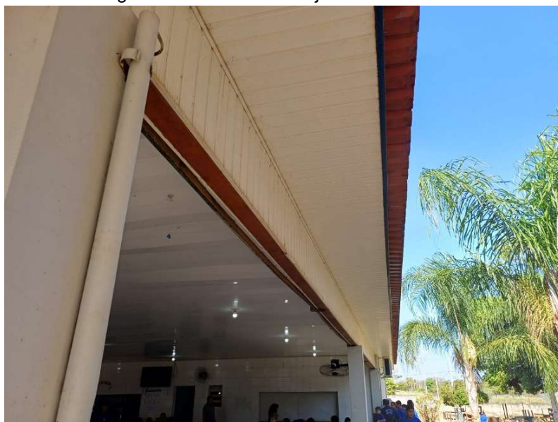
Figura 4 – Vista do beiral junto ao refeitório.
